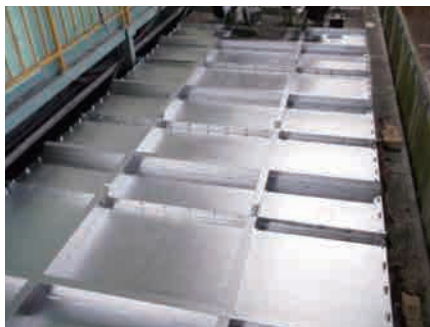
塗装後上部外観
