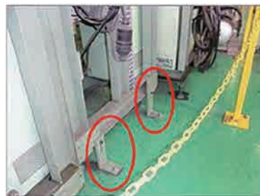
(事例)設備のアンカー固定
