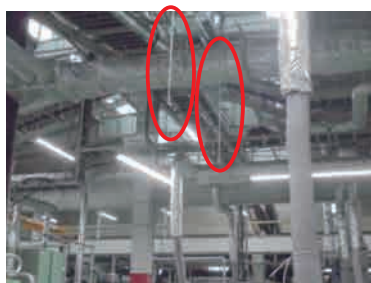
(事例)高所設備の落下防止
