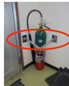
(事例)消火器転倒防止
